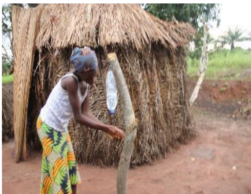
Latrine familiale avec un dispositif de lavage des mains.
